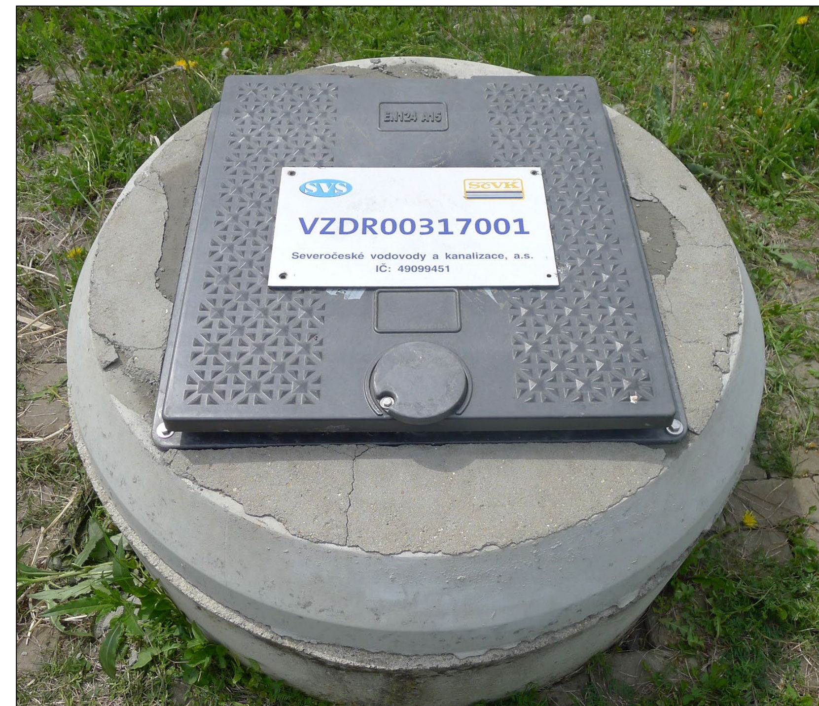
Pohled na šachtu vrtané studny KH-3
