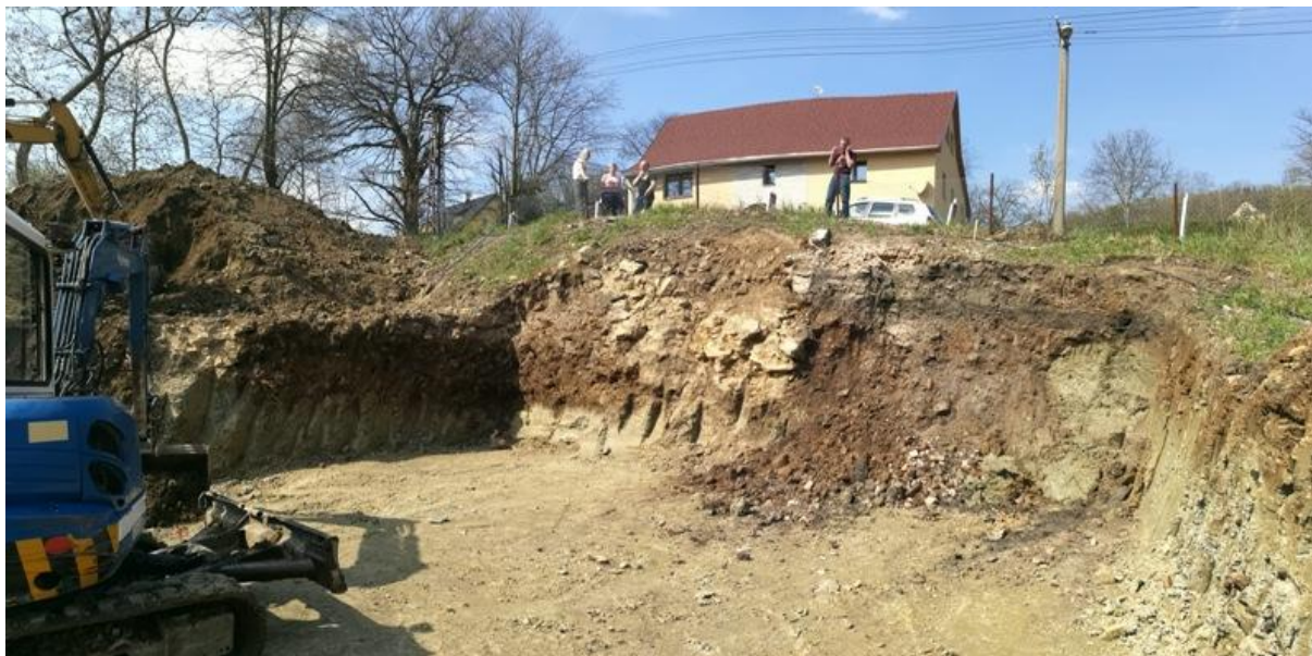
Obr. 6 Celkový pohled na stavební jámu situovanou v sesuvu.
